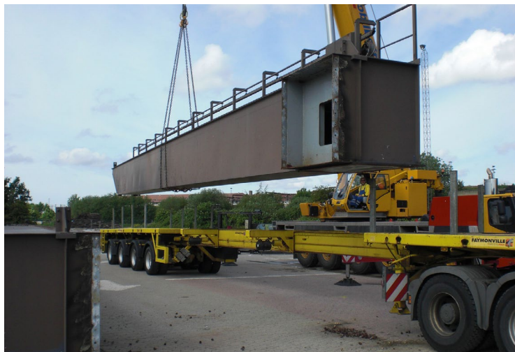
Transport von Kranteilen
